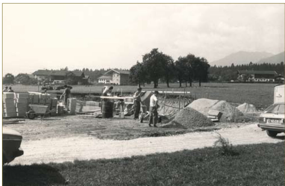
8. - 9. Oktober 1982: Emsiges Treiben auf der Baustelle: Betonieren der Fundamente
