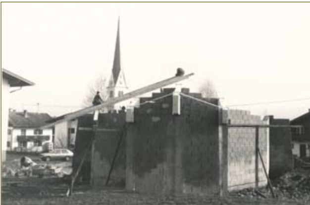
19. - 20. Oktober 1982: Vollendung der Dachkonstruktion
