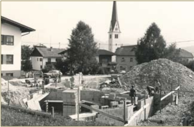
8. - 9. Oktober 1982: Aufmauern des Kellers
